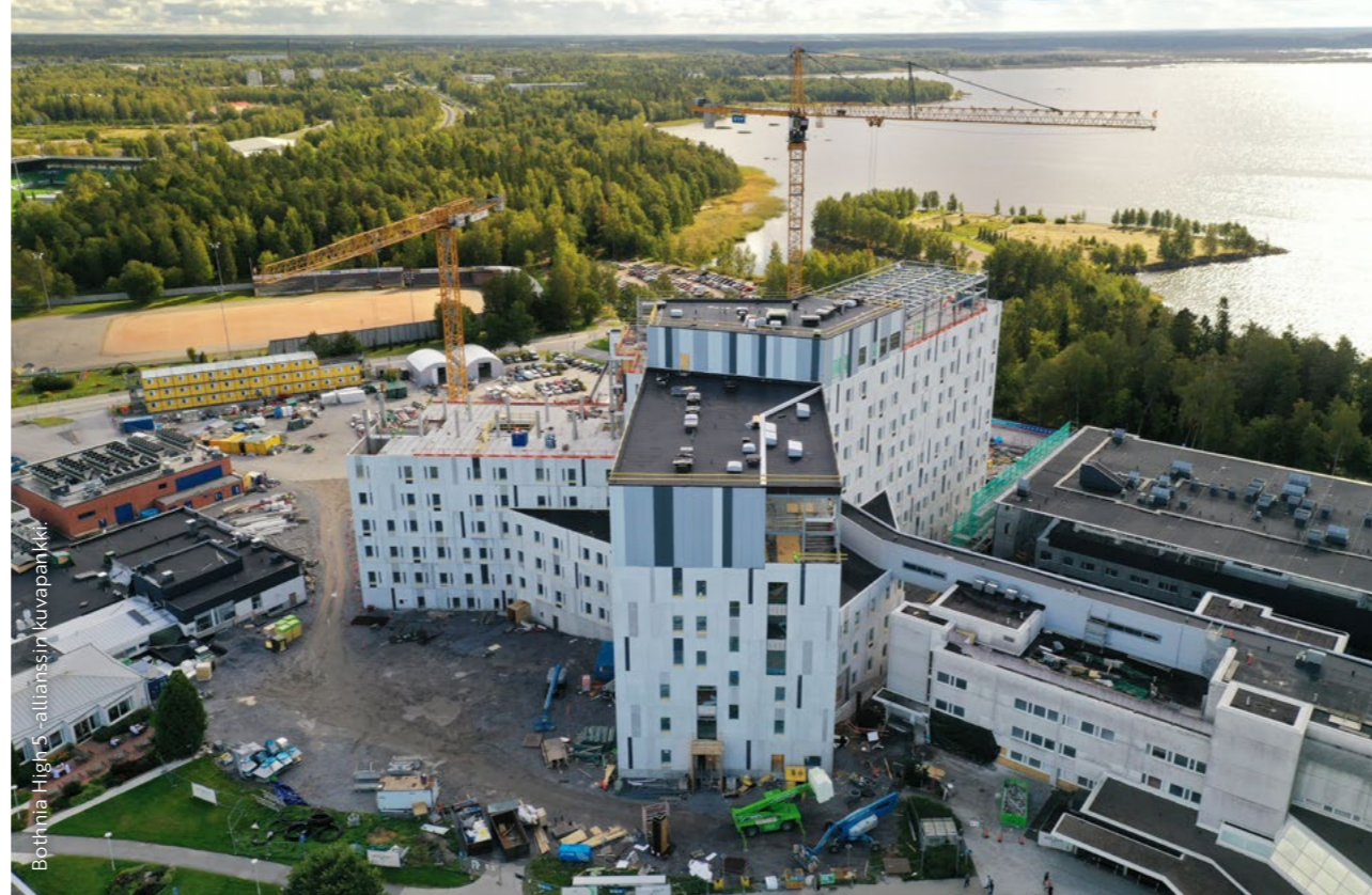
Sairaalaprosjektissa siirryttiin toteutusvaiheeseen kesällä 2019, ja nyt pystyssä on kymmenkerroksinen sairaalarakennus. Kuva on vuodelta 2020.
